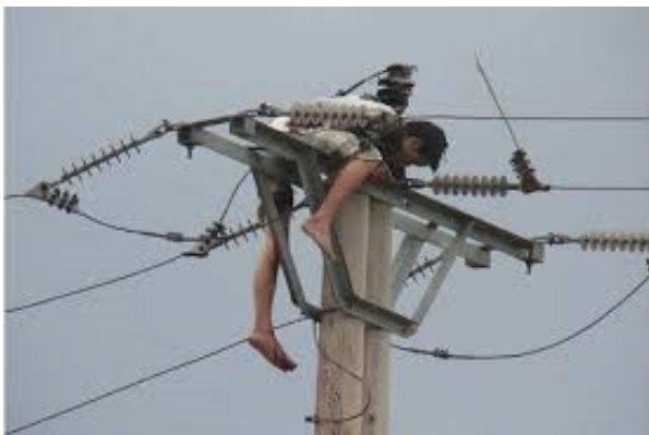
Học sinh chơi leo cột điện, bị điện giật chết
